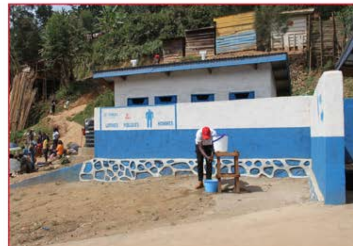
Fin des travaux
