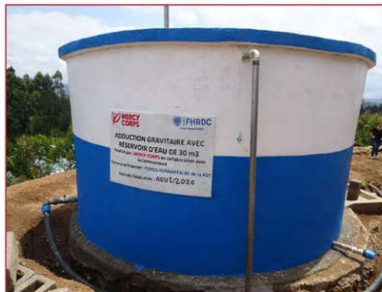
Fin des travaux
