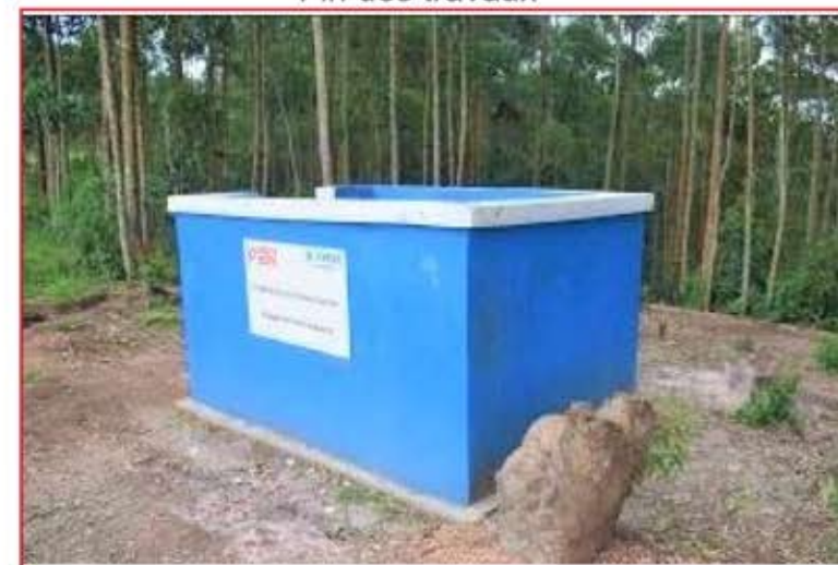
Fin des travaux
