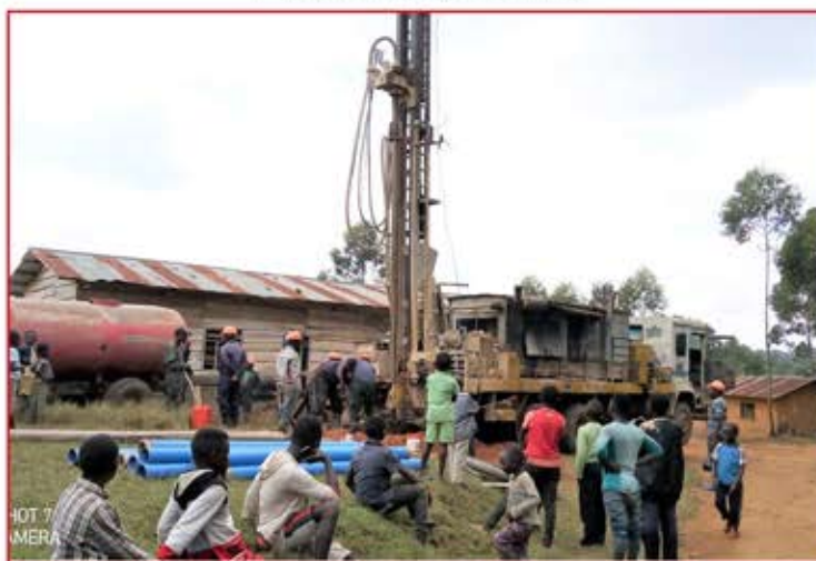
Pendant les Travaux
