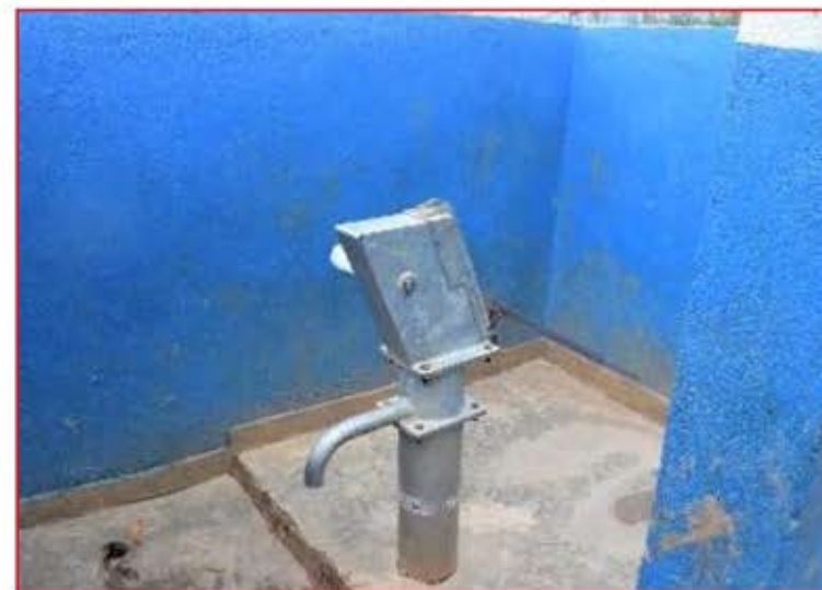
Fin des travaux
