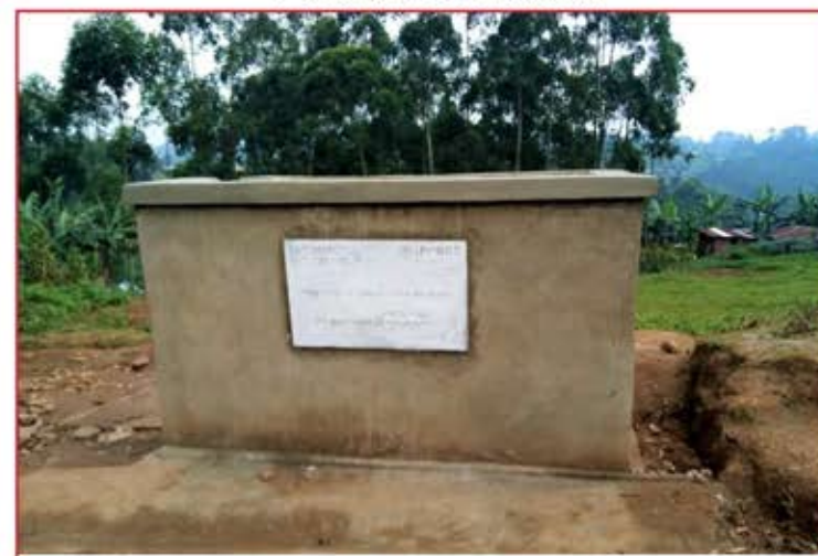
Pendant les Travaux
