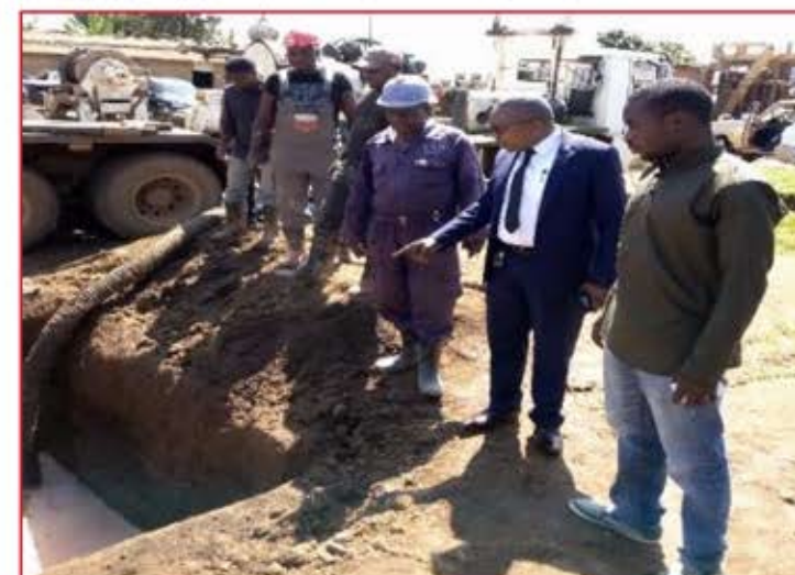
Visite de chantier du forage par le Bourgmestre
