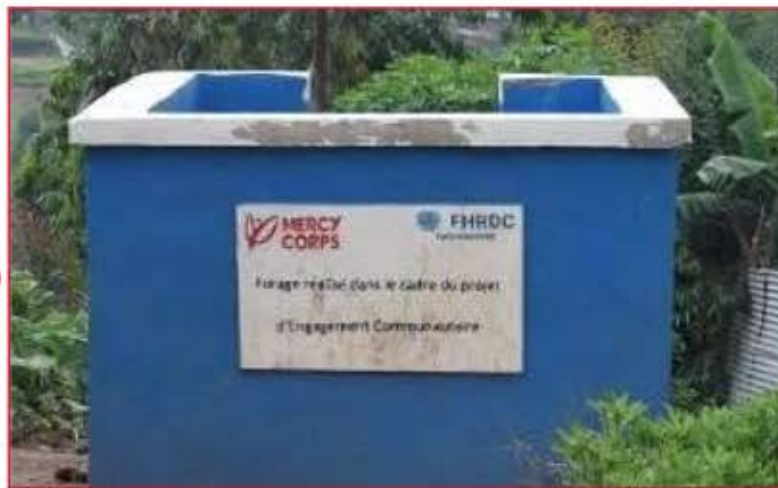
Fin des travaux
