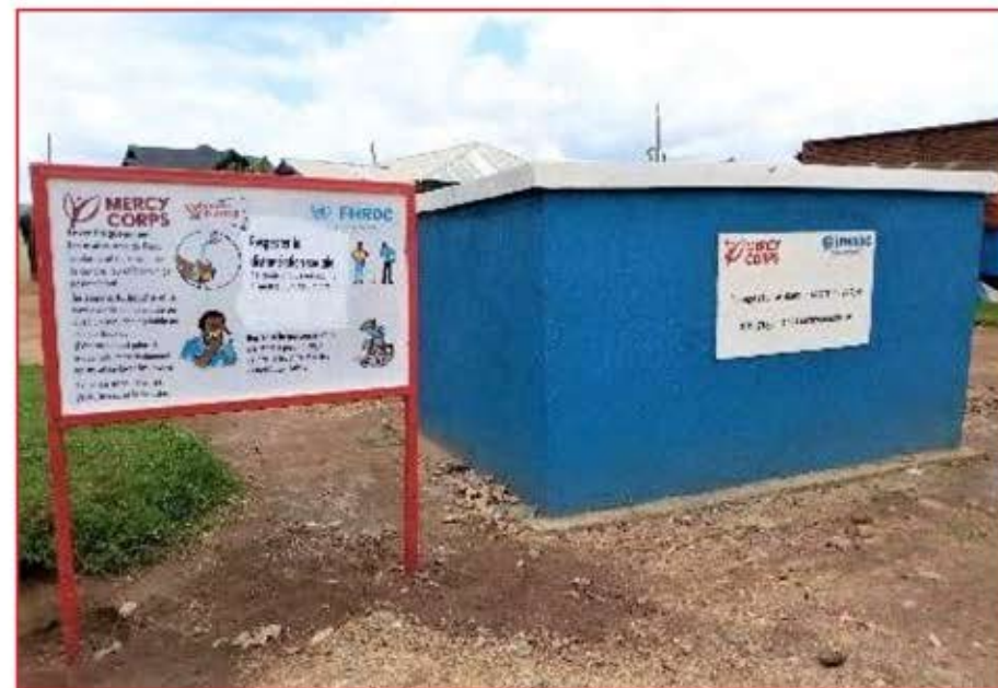
Fin des travaux
