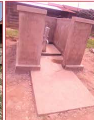
Pendant les Travaux
