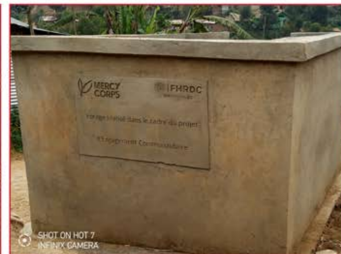
Pendant les Travaux
