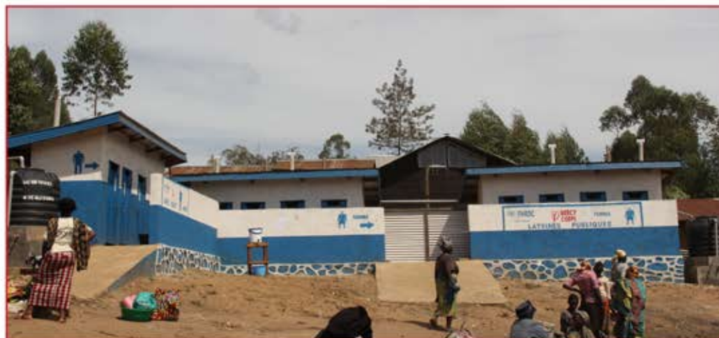
Fin des travaux
