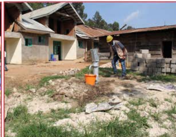
Pendant les Travaux
