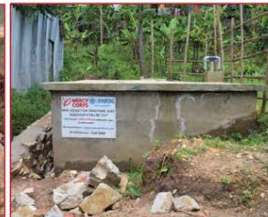
Reservoir de 12 m3
