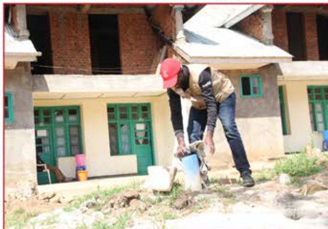
Pendant les Travaux
