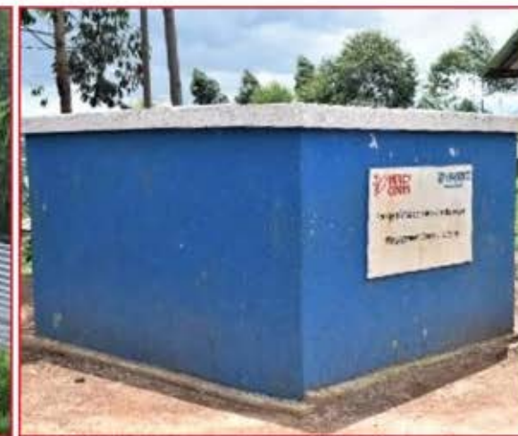
Fin des travaux
