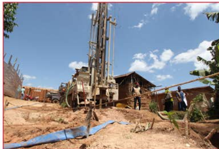
Pendant les Travaux
