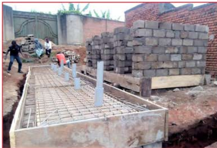
Pendant les Travaux
