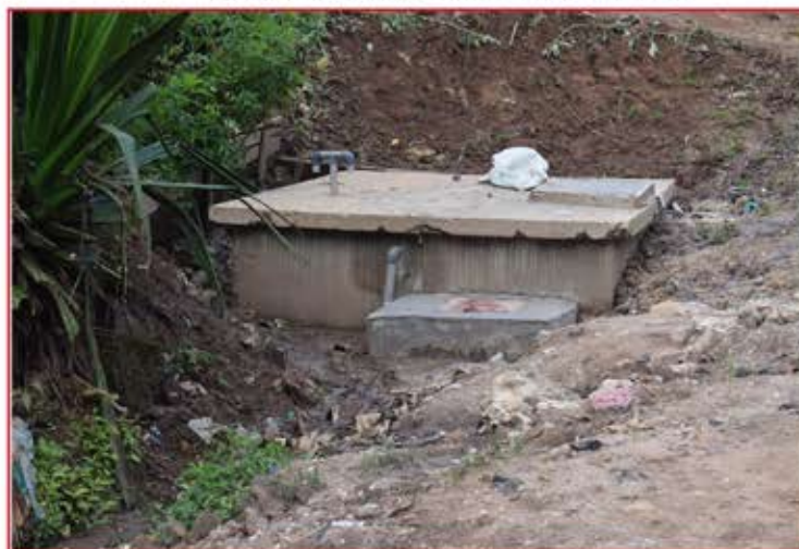
Source avec reservoir de 3 m3
