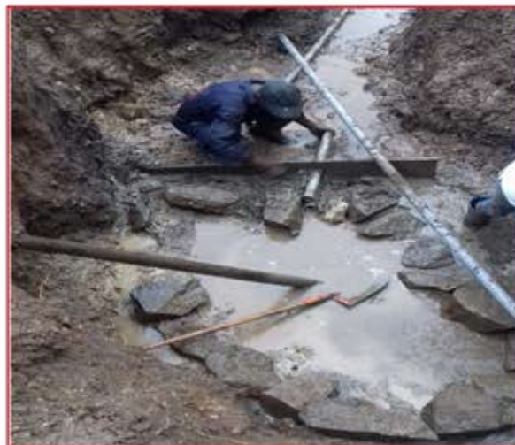
Pendant les travaux
