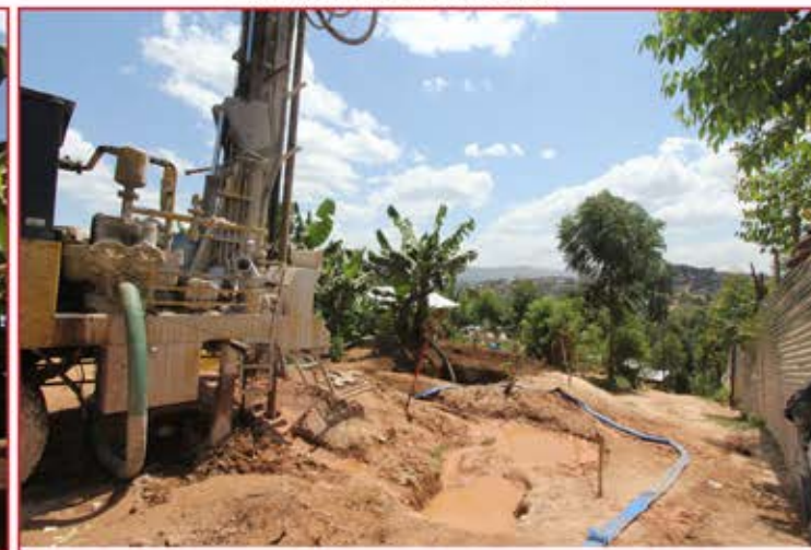
Pendant les Travaux
