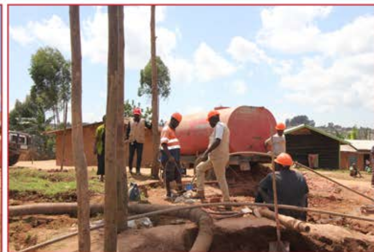
Pendant les Travaux
