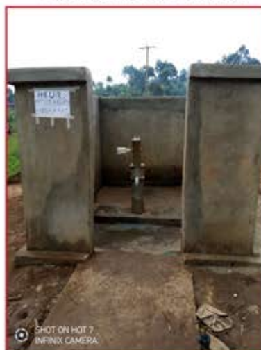
Pendant les Travaux
