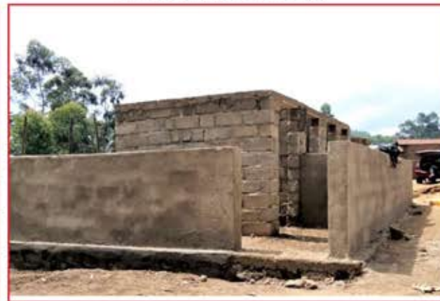
Pendant les Travaux
