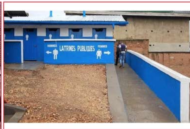
Fin des travaux
