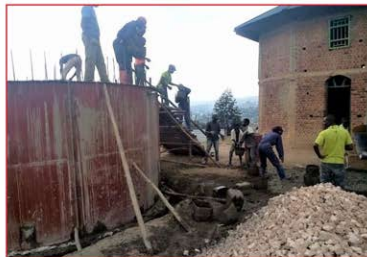
Pendant les Travaux
