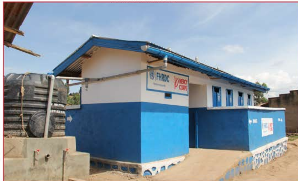
Fin des travaux
