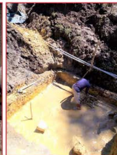
Pendant les Travaux
