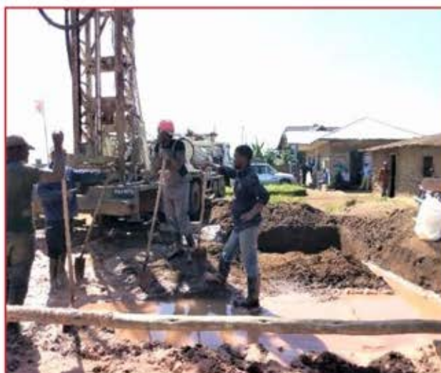
Pendant les Travaux
