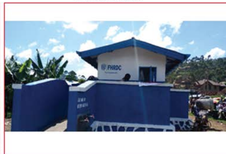
Fin des travaux
