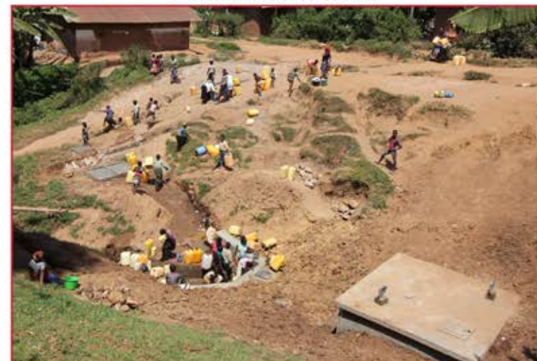
Pendant les Travaux
