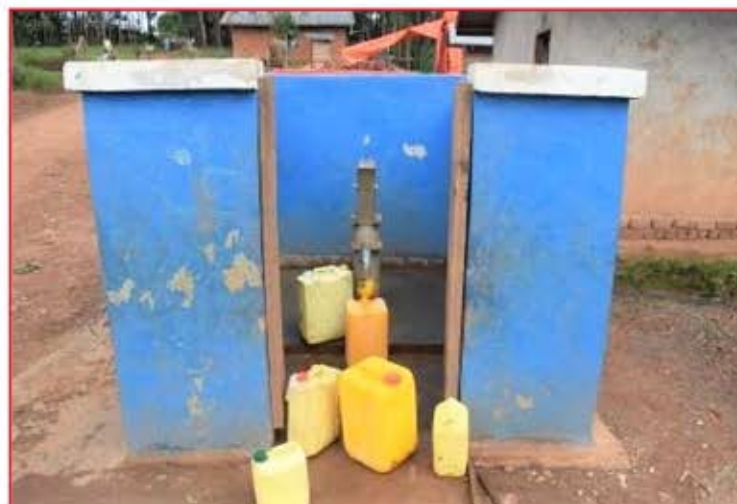
Fin des travaux
