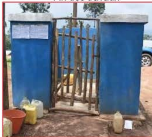
Fin des travaux
