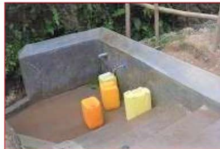
Fin des travaux
