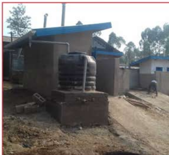
Fin des travaux
