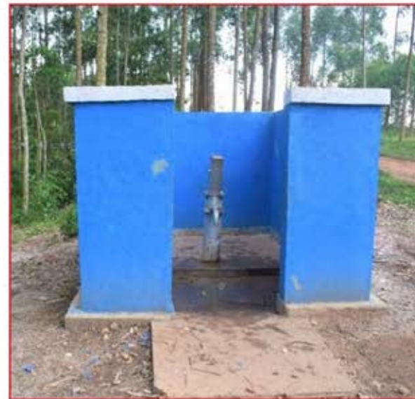
Fin des travaux
