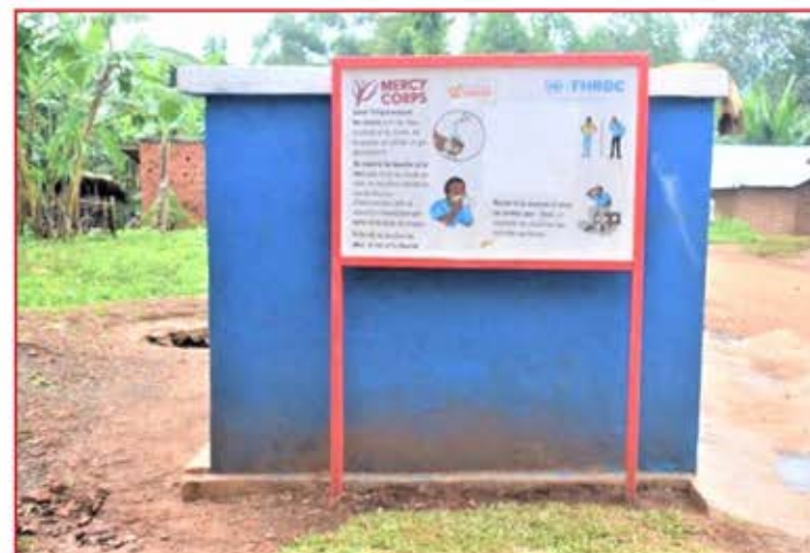
Fin des travaux
