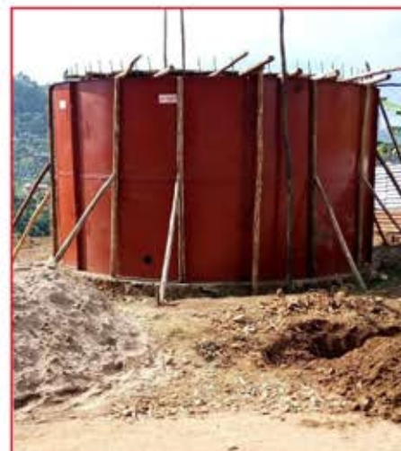
Etape de construction
