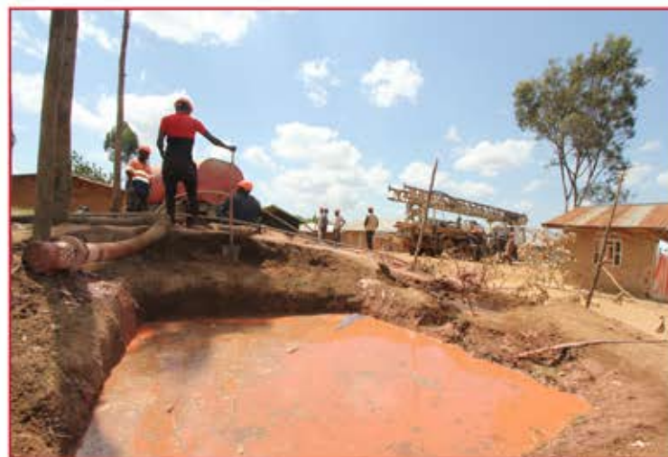
Pendant les Travaux
