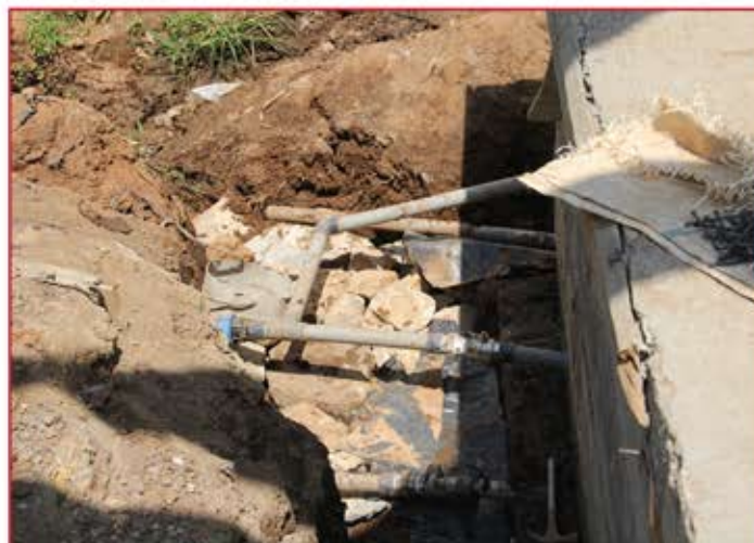
Pendant les Travaux
