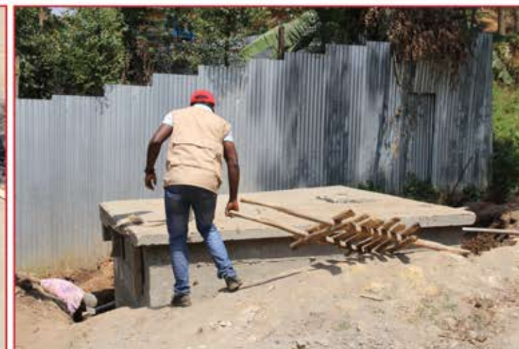
Pendant les Travaux
