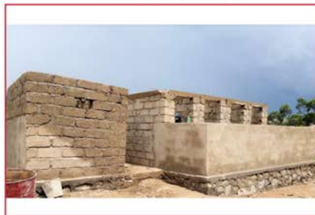
Pendant les Travaux
