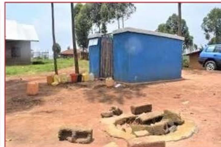
Fin des travaux
