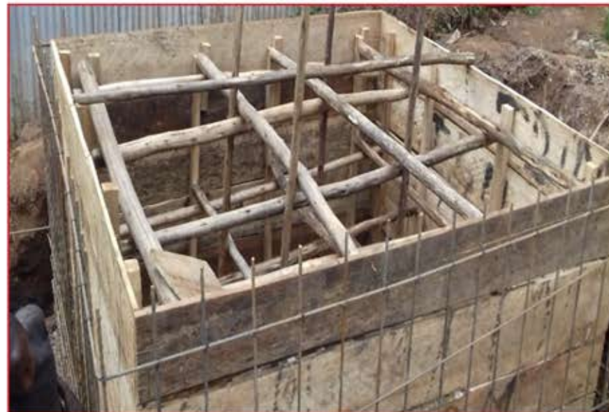
Pendant les Travaux
