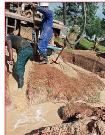
Pendant les Travaux
