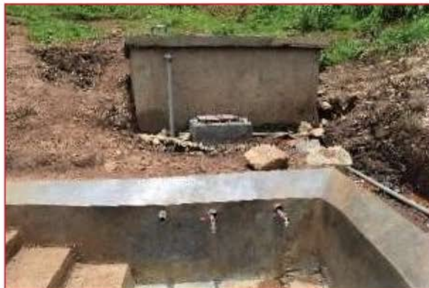
Pendant les Travaux
