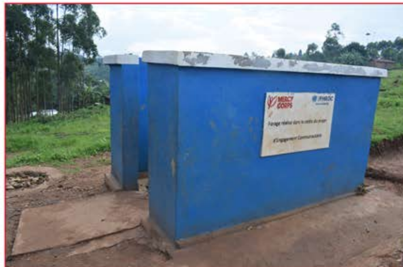
Fin des travaux
