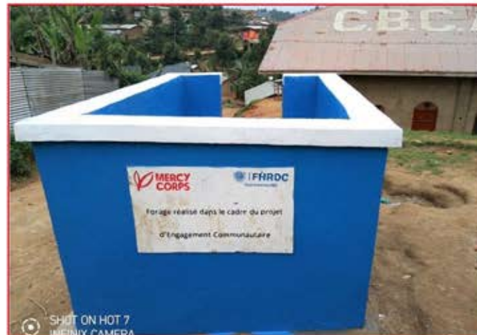
Fin des travaux
