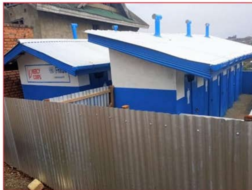
Fin des travaux
